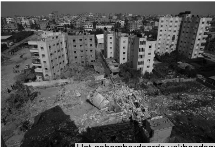
Het gebombardeerde vakbondsgebouw van de vakbeweging PGFTU
